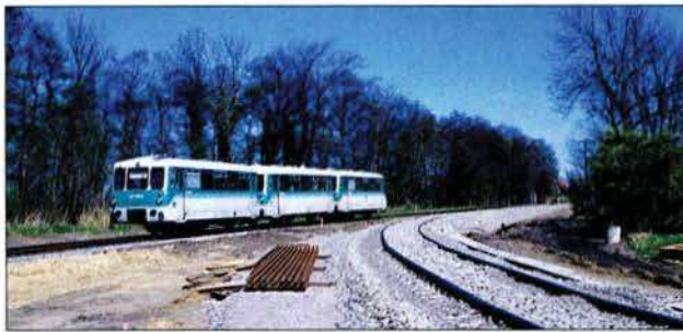
Das Anschlußgleis auf der Inselseite zur Peenebrücke liegt bereits.
