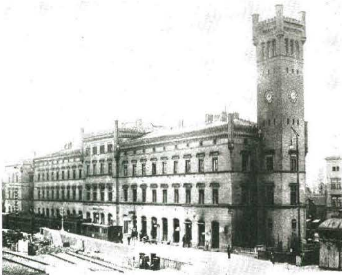
Bild 2 Das Empfangsgebäude Erfurt um 1880, das seinerzeit gleichzeitig Sitz der Direktion der ThEG war.
