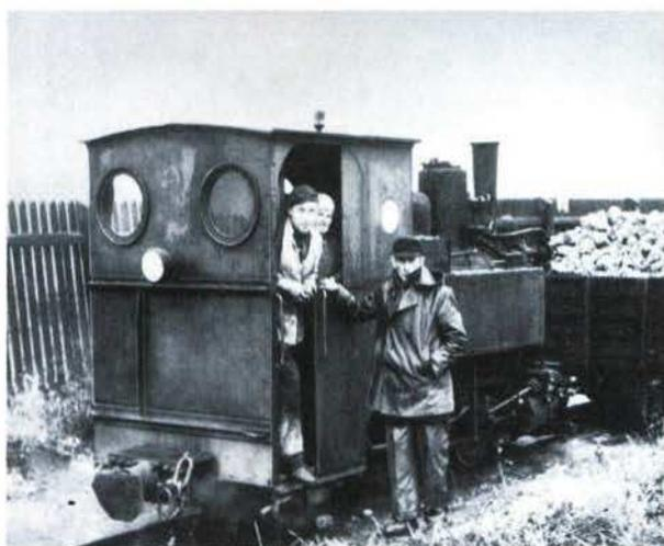
Bilder 1 und 2 Seit dem Jahre 1901 verfügte die Zuckerfabrik Jarmen über eine 600-mm-spurige Werkbahn mit einer Länge von 2,215 km. Neben der Güterwagenüberführung zur ebenfalls an diese Anlage angeschlossenen Mecklenburg-Pommerschen Schmalspurbahn (MPSB) diente die Werkbahn Kohlentransporten vom Peene-Stückkanal der Zuckerfabrik bis zur Kesselanlage. 1966 wurde hier der Betrieb eingestellt.
