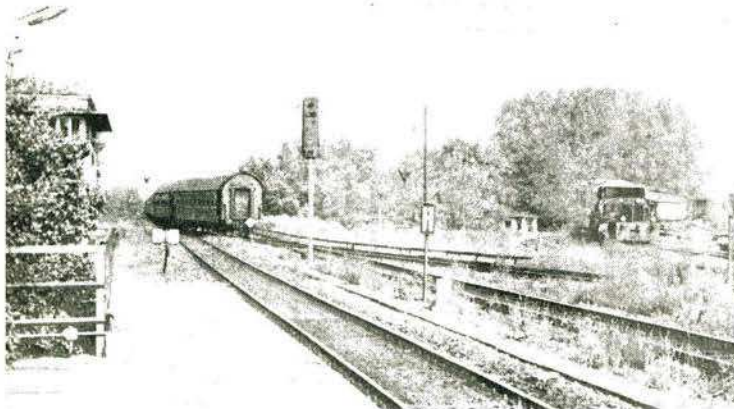
Bild 5 Der D 114 aus Köln verläßt den Bf Königs Wusterhausen in Richtung Berlin. In der Bildmitte befindet sich das S-Bahngleis, kenntlich an der Stromschiene. Rechts zweigt die Strecke nach Grunow ab. Auf dem Gleis zum Hafen Königs Wusterhausen steht ein Bauzug.
