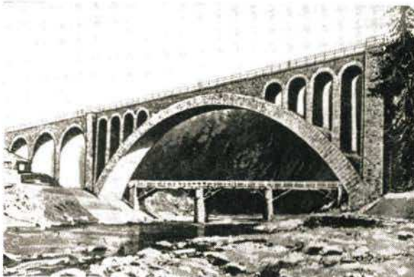
Bild 59 Eisenbahnbrücke über den Pruth
