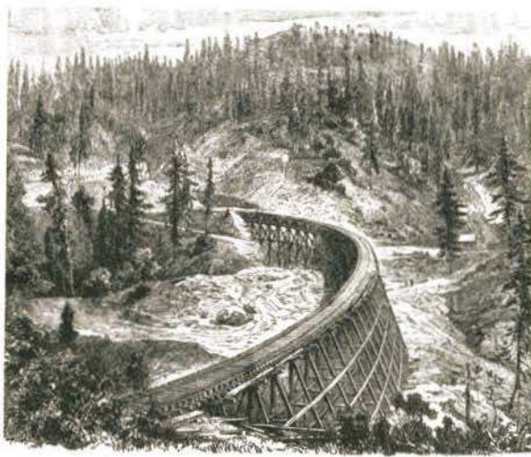
Bild 57 Holzgerüste als Unterbau in Amerika (trestle works)
