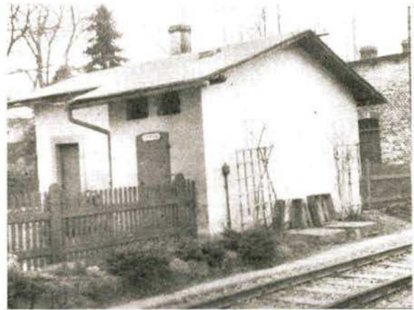
Bild 7 Abortgebäude, ebenfalls vom Gleis aus gesehen
