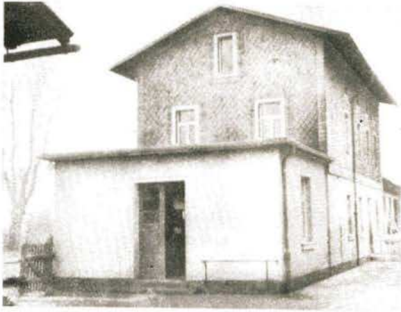
Bild 4 Ansicht des EG mit Warteraumanbau
