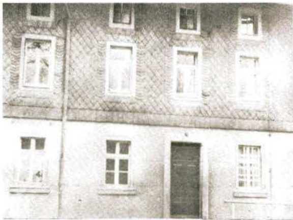
Bild 5 Straßenseite, deutlich ist die Anordnung der Schieferverkleidung und Fensterumrahmung erkennbar
