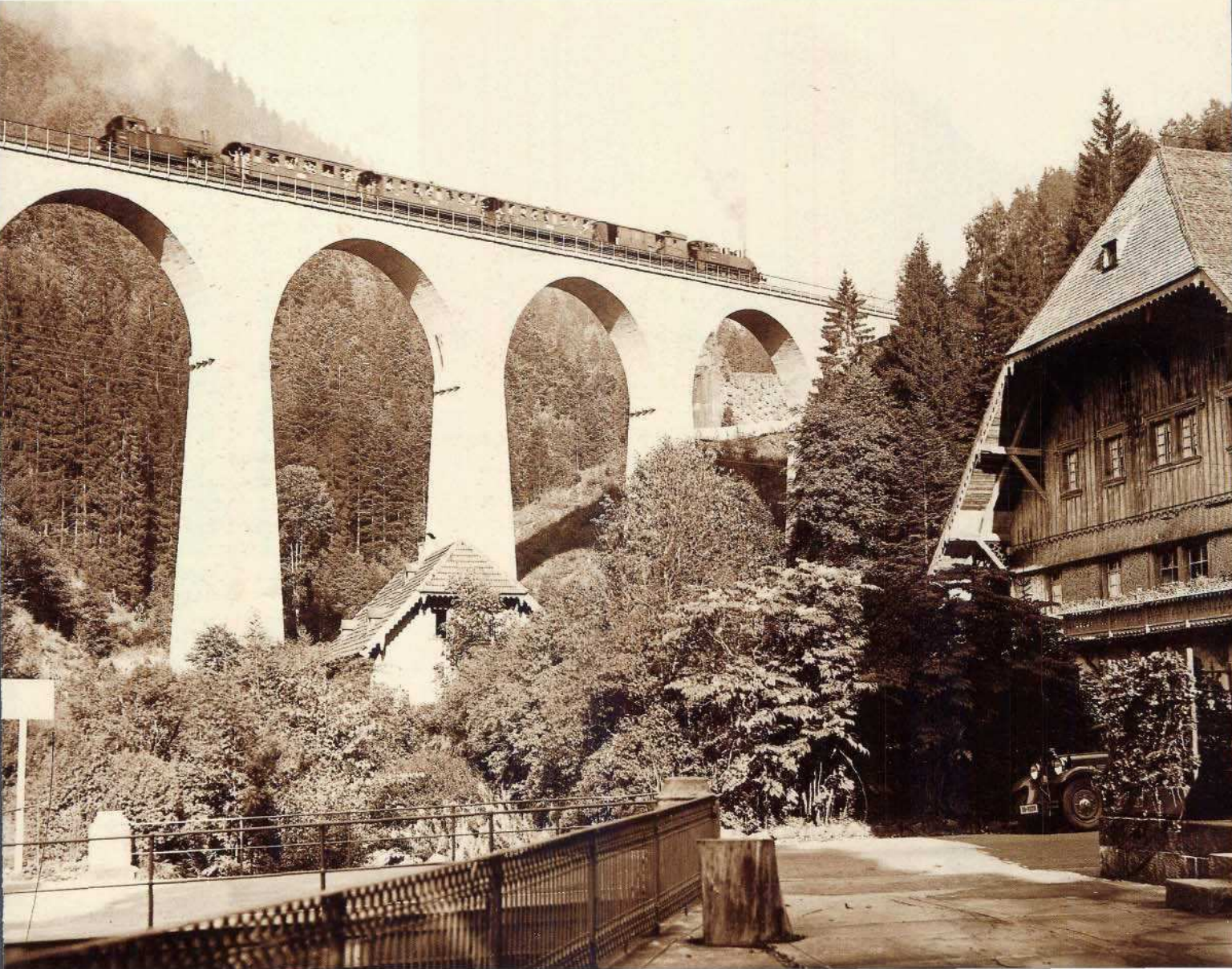
Bild 1: Auf dem neuen Ravennaviadukt der Höllentalbahn fährt ein Zug bergwärts Richtung Hinterzarten. Die Zuglok der bad. Gattung VI b erhält Schubunterstützung von einer Zahnradlok der bad. Gattung IX b. Abb.: Rbd Karlsruhe (Archiv BD Karlsruhe), Sammlung Ritz
