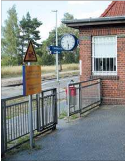
Hier ist der Zugang zum Hausbahnsteig über eine Sperre gesichert. Die Bedienung erfolgt manuell durch das Stationspersonal.
