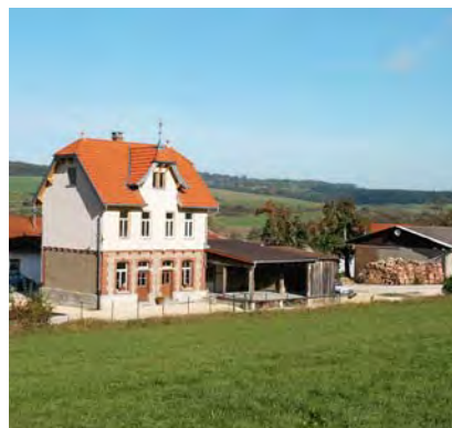
Liebevoll restauriert: Der Bahnhof Dischingen, der künftige Endpunkt.
