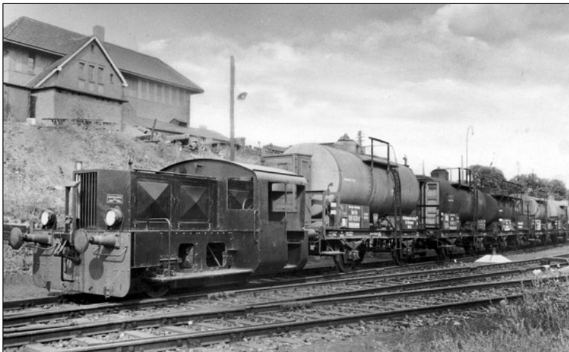
Zwar ist diese Aufnahme von O & K vermutlich eher zur Präsentation der Kleinlok entstanden als wegen der Kesselwagen, aber in diesem Buch sind letztere das Hauptmotiv: fünf Verbandsbauartwagen, vorn der Berlin 591 635 [P] der Reichsmonopolverwaltung für Branntwein, an dritter Stelle ein Dreikammerwagen. (Foto O & K, Slg. SC)
