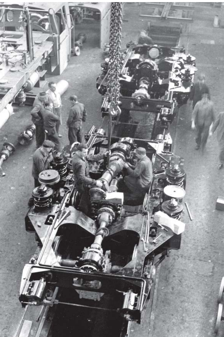
Montage der Gelenkwelle vom Zwischengetriebe zum mittleren Radsatz im Drehgestell: Deutlich sichtbar ist die Federung der Kastenabstützung, die im Einsatz bereits nach kurzer Zeit nachgebessert werden musste.
